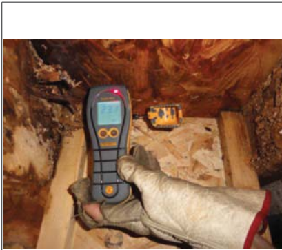
Underneath deck door
